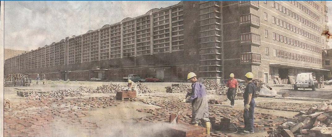
Mit einem Wasserdruck von 500 Bar werden die nicht mehr benötigten Klinkersteine der beiden zum Abriss freigegebenen Anbauten gereinigt. Man braucht sie, um Schäden an der Fassade der denkmalgeschützten Halle auszubessern.
